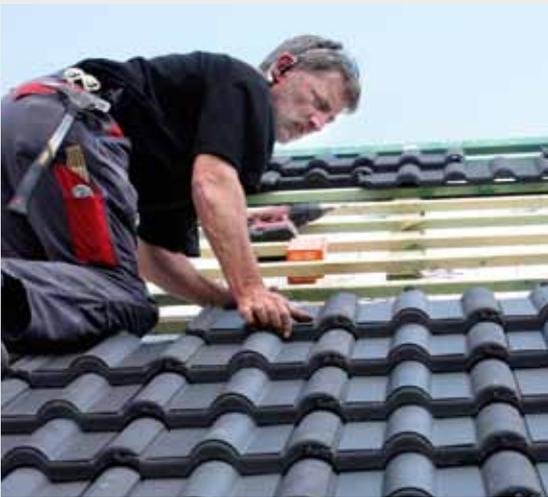
Die Solar-Dachpfannen-Kollektoren werden durch ein Stecksystem miteinander verbunden. Dadurch entsteht eine komplette Kollektorfläche auf dem Dach, die optisch kaum zu sehen ist. Die Solar-Dachpfannen-Kollektoren werden derzeit in den Farben Schwarz, Granit, Braun und Rot produziert.
