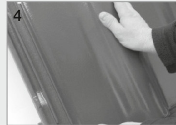
4 De volgende dakpan indekken en aandrukken. Klaar!
