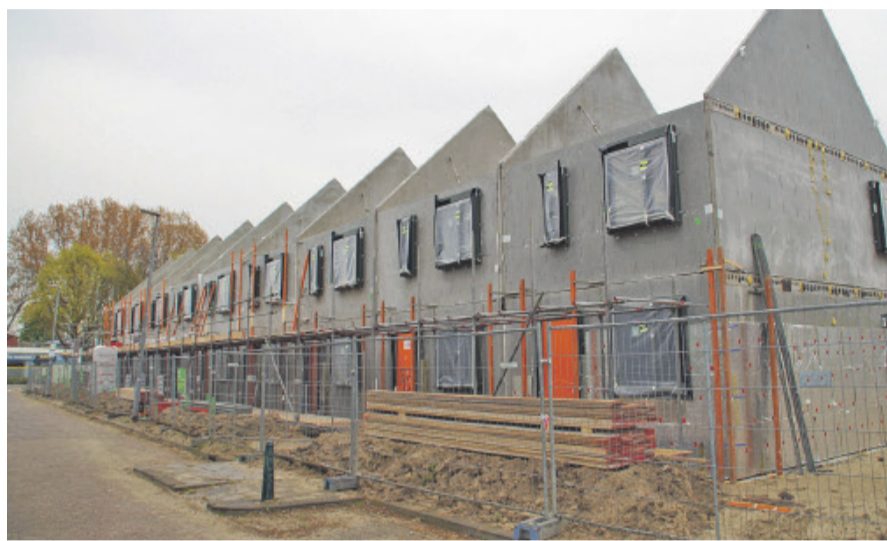
▲ Aannemer BM Van Houwelingen bouwde in de Sagenbuurt 106 nieuwe woningen. Vloerverwarming Zuid BV legde de vloerverwarming aan.
