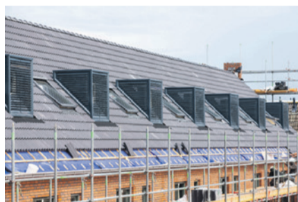
▲ Geen traditionele dakkapellen, maar innovatieve dakkappen waaronder de Daikin Altherma 3 lucht- waterwarmtepomp schuilgaat. De dakpannen zijn Nelskamp Climalife antraciet betonpannen.
