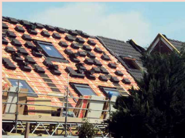
De aanleg van een Clima Life antraciet S pannendak in Weert.
