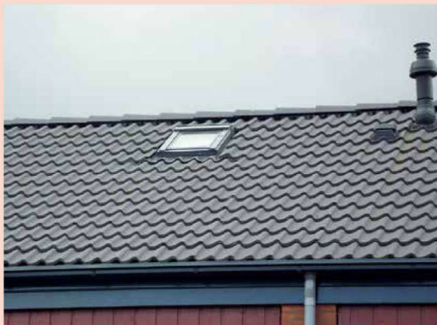
Nelskamp Clima Life antraciet S pan op het dak van een project in Wervershoof.
